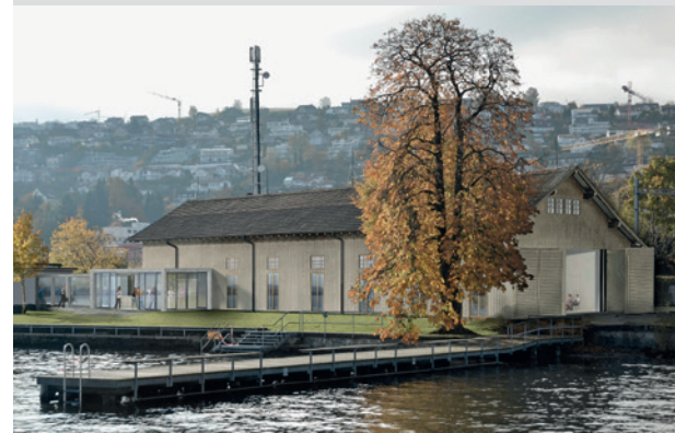
Ansicht umgebaute Remise seeseitig
