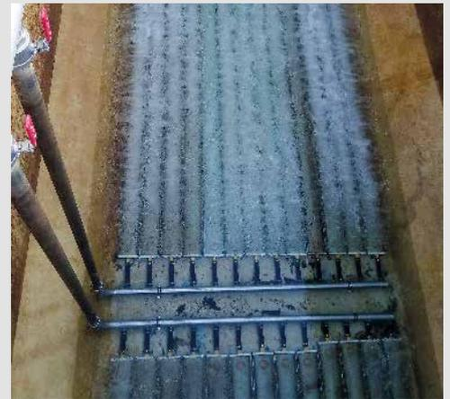
Die Belüftung wird getestet: Die Luftblasen zeigen auf, ob die Membranen funktionieren.
