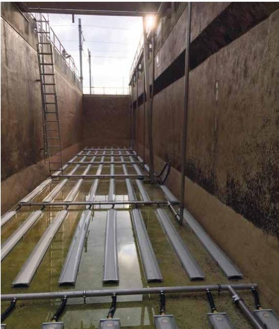
Wesentlicher Bestandteil des ARA Projekts ist der Ersatz der Belüftermembranen. Die neuen Membranen stellen sicher, dass die für die Entwicklung der Mikroorganismen optimale Umgebung geschaffen werden kann (Sauerstoffeintrag).
