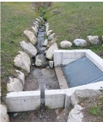
Entlastungsbauwerks bei Normalwasserabfluss
