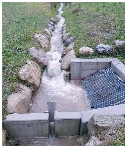
Entlastungsbauwerks bei Hochwasserabfluss
