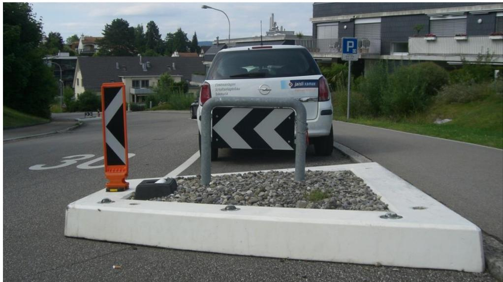
Abbildung 24: Beispiel Fertigelement für Sofortmassnahme in Oberrieden
