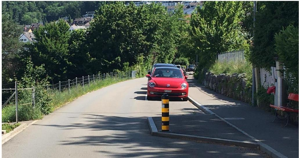
Abbildung 25: Beispiel Fertigelement für Sofortmassnahme in Oberrieden
