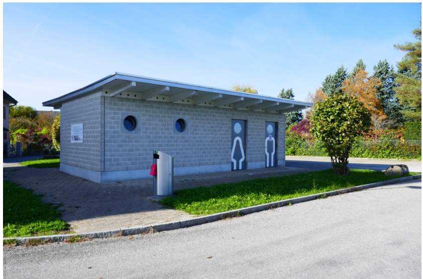
Bestehendes Nebengebäude mit öffentlichen Toiletten und Materialraum
