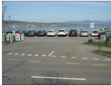
Parkplatz auf dem Dach der ‚Alten Braui‘
