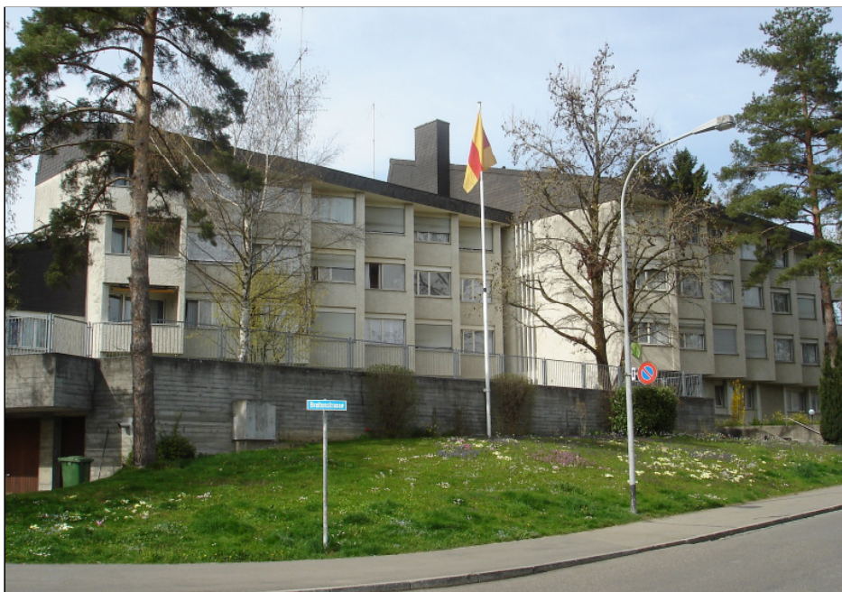
Die Breitenstrasse 1 ist stark renovationsbedürftig. In Kürze fallen hohe Investitionen an.
