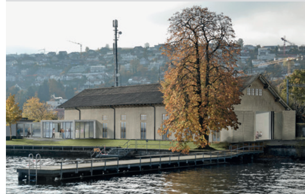
Ansicht umgebaute Remise seeseitig
