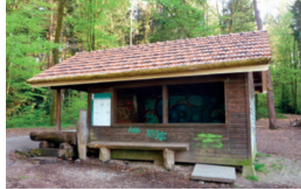
Dachsanierung Reidholzhütte, April 2014
