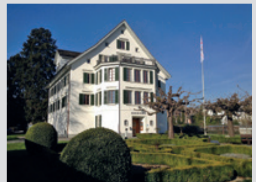
Die Fassade des Gemeindehauses 1 mit der frisch gestrichenen Fassade.
