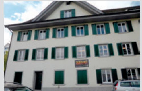
Das Jugend- und Freizeitzentrum Bürgi mit neuen Fenstern und neuen Fensterläden
