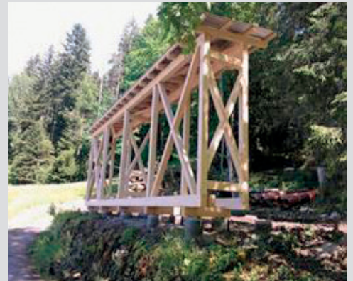
WK Forst, Erstellen eines Holzlager-Unterstandes bei der Forsthütte Mistlibühl.
