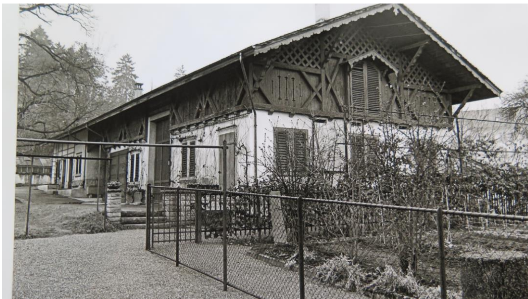
Ehemalige Kutschenremise mit Pferdestall, Gärtnerhaus, Treibhaus 1970
