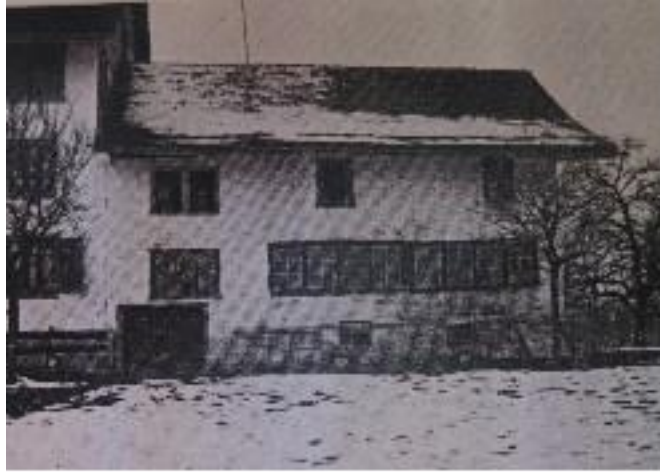
Schulhaus von 1760, Aufnahme um 1900
