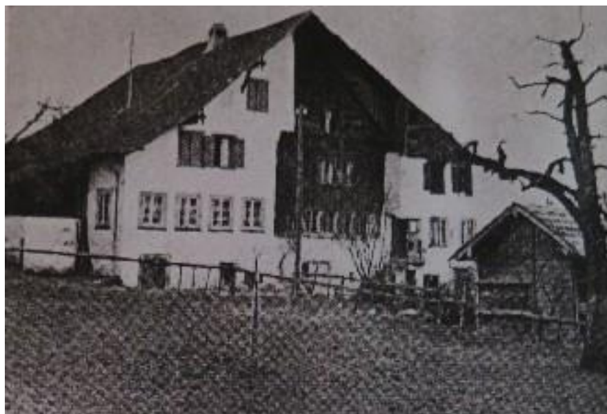
Ehemalige Schulstube Fälmis 1930, Abbruch 1939
