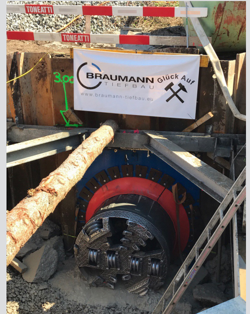
Durchbruch Micro Tunneling
