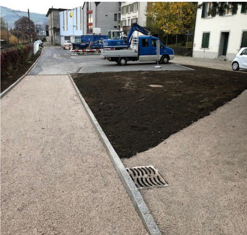
Erschliessung Gerbestrasse beim «Bürgi»
