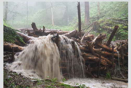
13.06.2018 Bachverbauung mit Stein und Schlamm zugedeckt
