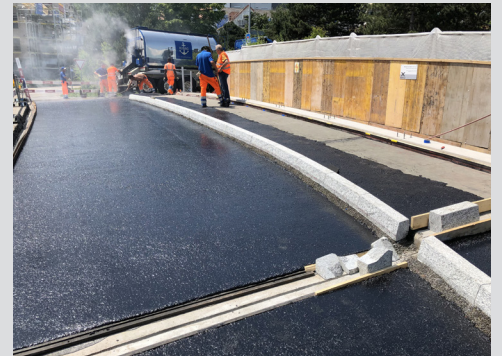
Einbau des Gussasphalts an der Hornbrücke
